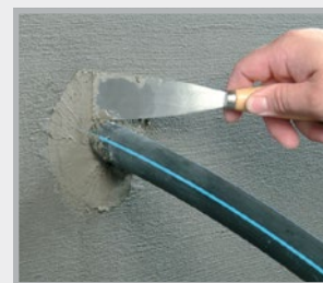
Verspachteln mit Schnellzement
