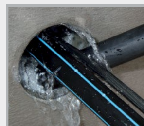
Einspritzen von FLEX 2000
