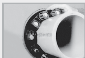
MASTER-SEAL in den Ringspalt einschieben
